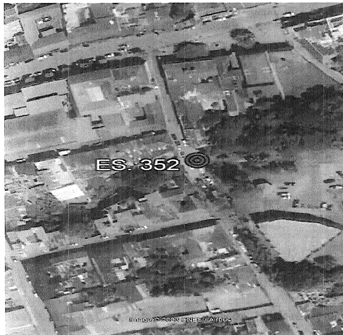
Imagen 2 Localización específica del Puente Fuente: Documentos Técnicos de estudios y Diseños - Municipio de la Mesa
